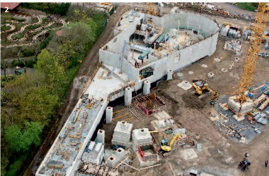
NOE den ersten zu schalenden Radius bereits werkseitig ein. So kann die NOEtop R 275 schnellstmöglich eingesetzt werden. Sind weitere Radien erforderlich, lassen sich diese mit wenigen Handgriffen einstellen. Um höhere Wände zu errichten, wird die Schalung einfach aufgestockt.
