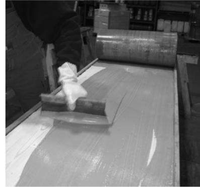
Remuer soigneusement la base A. Ajouter le durcisseur B à la base A et remuer jusqu'à l'obtention d'un mélange homogène. Versez le mélange dans un deuxième récipient et mélanger à nouveau soigneusement. Capacité de charge au plus tôt au bout de 24 heures environ. Nettoyer les outils avec un diluant.
