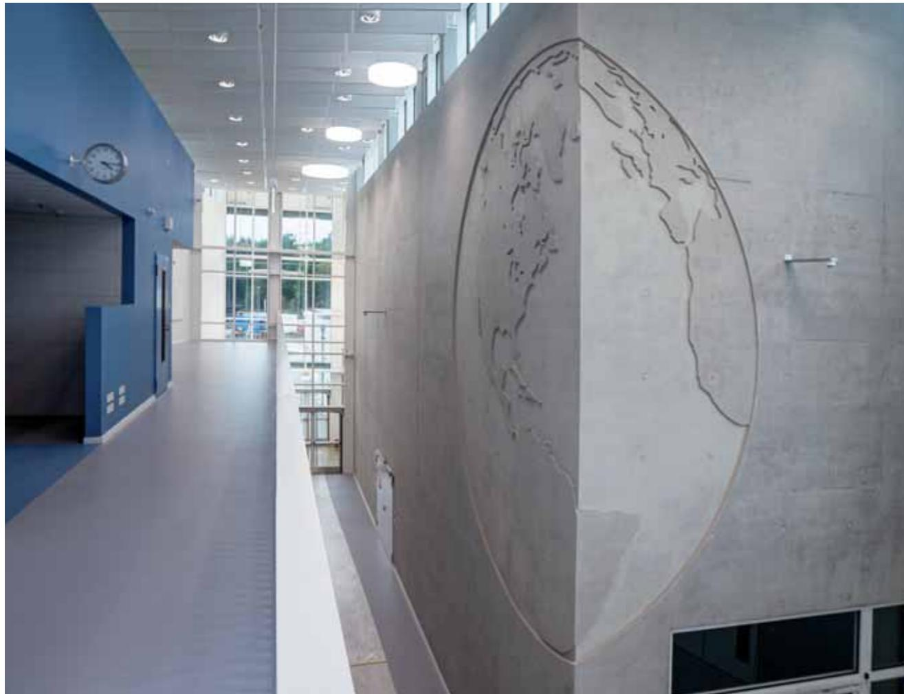
■ NOEplast – une plus grande individualité grâce aux structures de coffrage à façonner soi-même
