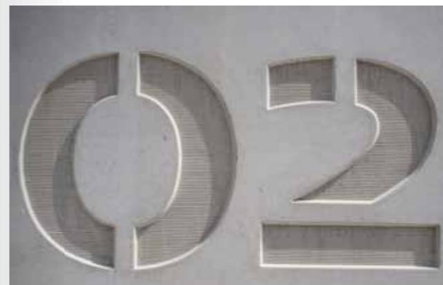
béton structuré proprement dite. Afin de faciliter la tâche aux architectes et concepteurs, NOE-Schaltechnik met à leur disposition des motifs divers et variés qu'ils peuvent reprendre à l'identique, modifier ou dont ils peuvent s'inspirer pour leurs propres créations.
