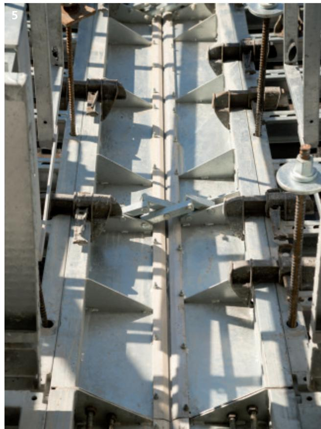
Arbeitsbühnen aufklappen und Richtstützen ausrichten – schon ist die NOEtop S einsatzbereit. Für den Transport auf die nächste Baustelle muss alles nur wieder eingeklappt werden. Eine Demontage der Sicherheitseinrichtungen zum Transport bzw. Lagerung ist nicht notwendig.
