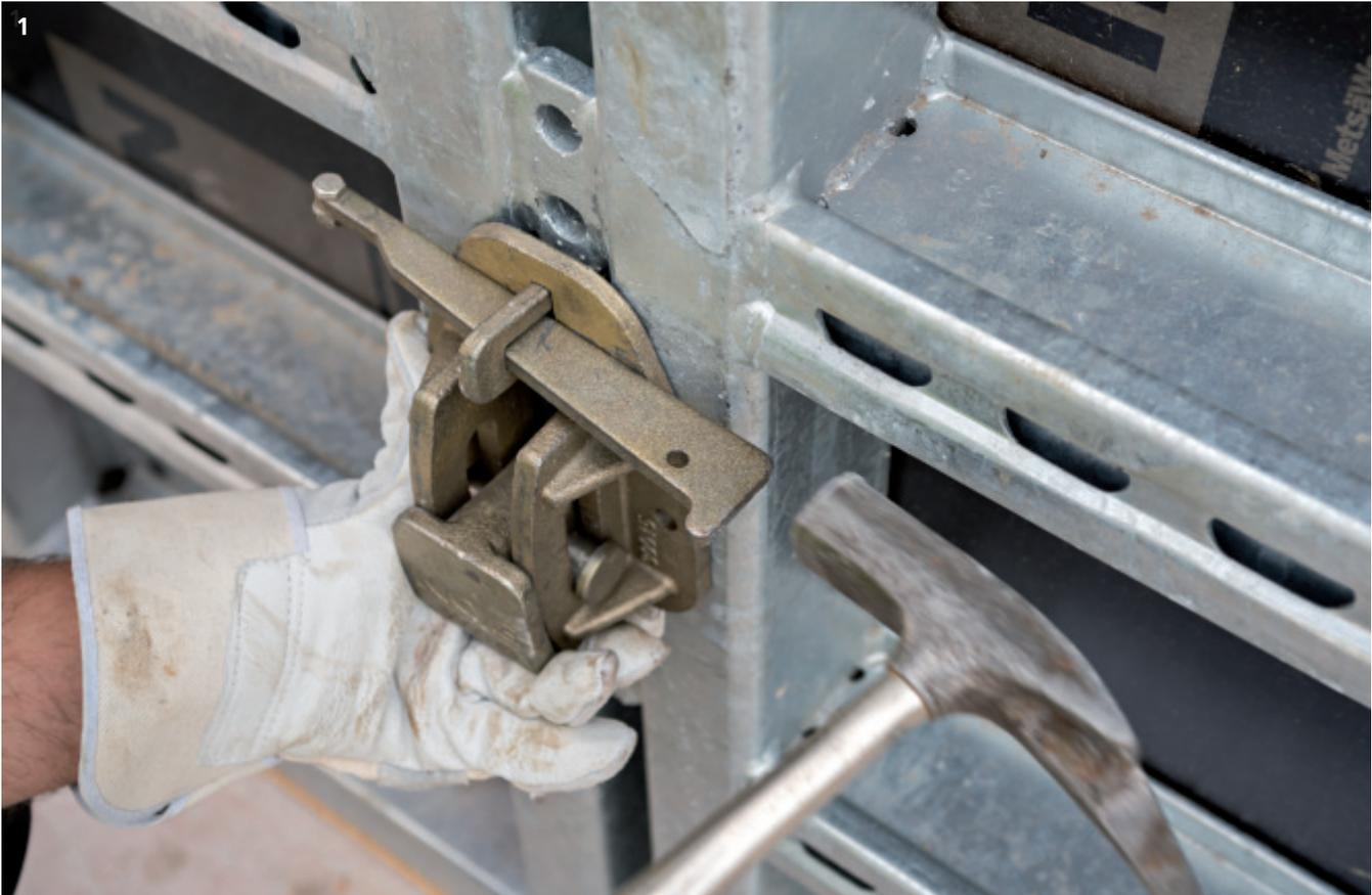
Das Thema Verankerungen bei Schalsystemen nur noch von einer Seite aus zu setzen erfreut sich derzeit großer Nachfrage. Dem wird NOE mit einer ganz besonderen Lösung gerecht und ergänzt sein NOEtop Schalsystem mit der einseitigen Ankertechnik NOEtop EinsA.
