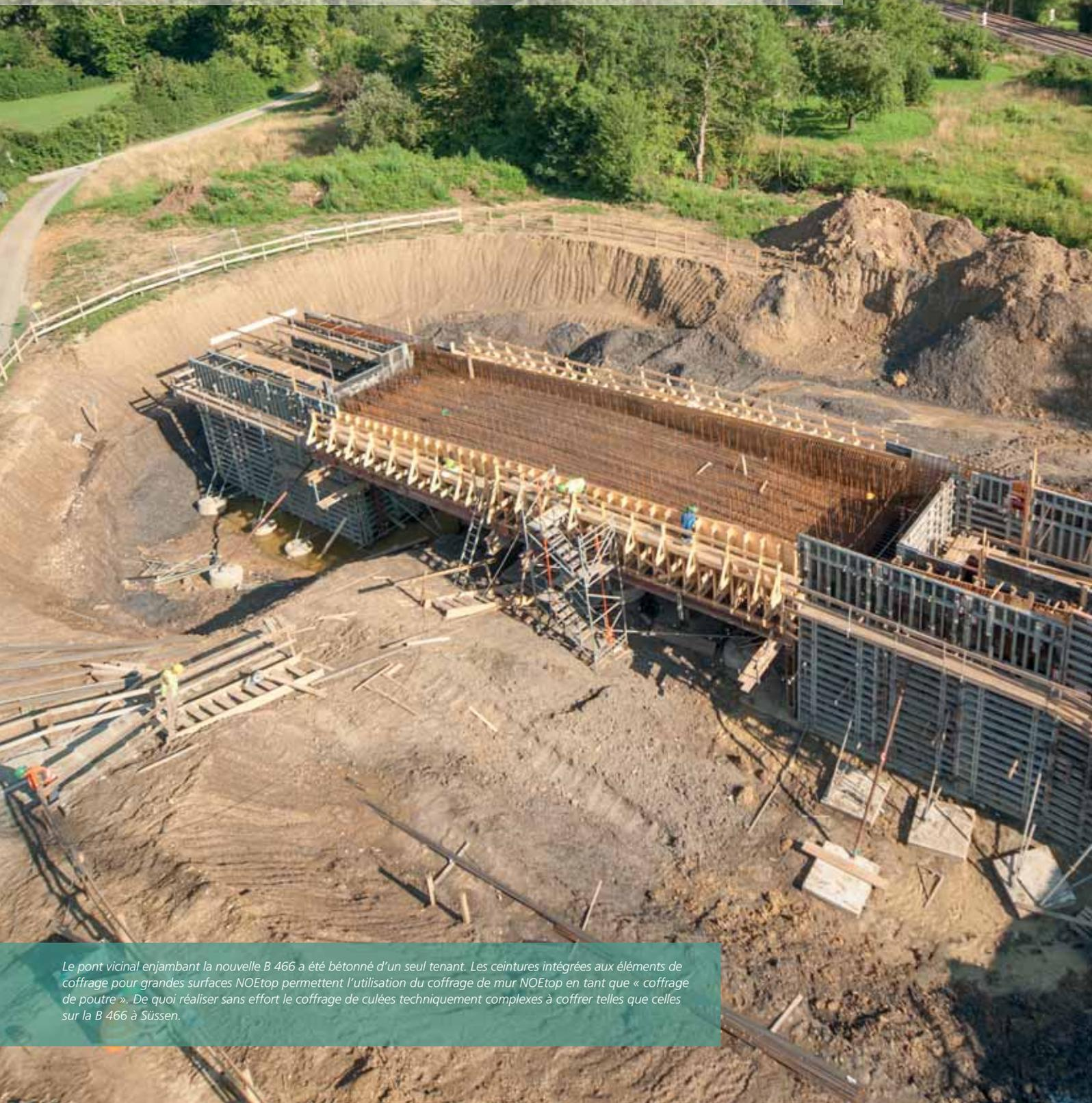
*Le pont vicinal enjambant la nouvelle B 466 a été bétonné d'un seul tenant. Les ceintures intégrées aux éléments de coffrage pour grandes surfaces NOEtop permettent l'utilisation du coffrage de mur NOEtop en tant que « coffrage de poutre ». De quoi réaliser sans effort le coffrage de culées techniquement complexes à coffrer telles que celles sur la B 466 à Süssen.*
