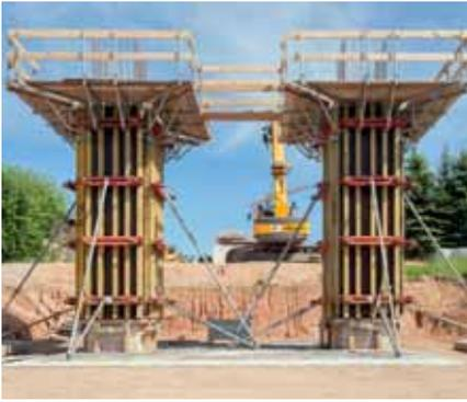
La trame sur une largeur de 25 cm du coffrage de poutre NOEratio s'est avérée être un réel avantage pour les sections filigranes des colonnes lors de la construction du pont traversant le Leutersbach.
