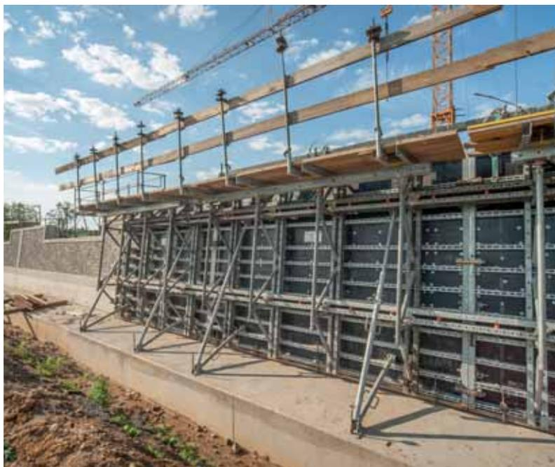
Les éléments présentaient des dimensions max. de 300 x 512,5 cm de sorte que des segments muraux de 9,60 m de long ont pu être bétonnés à l'aide de quatre éléments de coffrage seulement.
