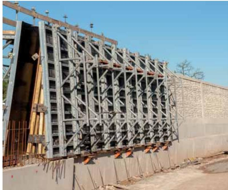
*Des vérins d'appui placés dans la partie inférieure ont permis un décoffrage opéré avec délicatesse.*
