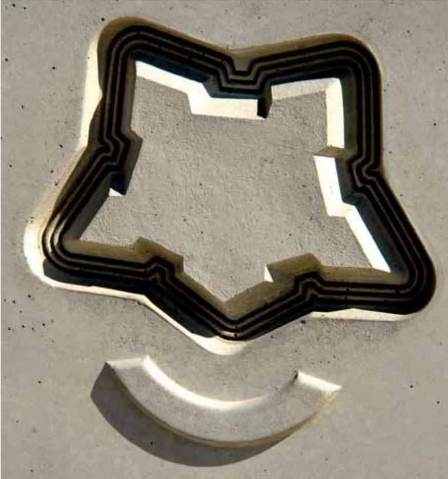
*Grâce à NOEplast, il a été possible de réaliser dans le béton des lignes très fines symbolisant l'eau dans les douves.*
