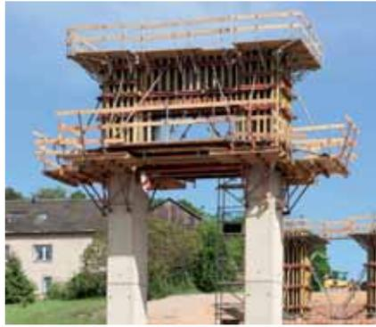
Le coffrage de poutre NOEratio a dévoilé tous ses avantages lors du coffrage des têtes de colonnes.
