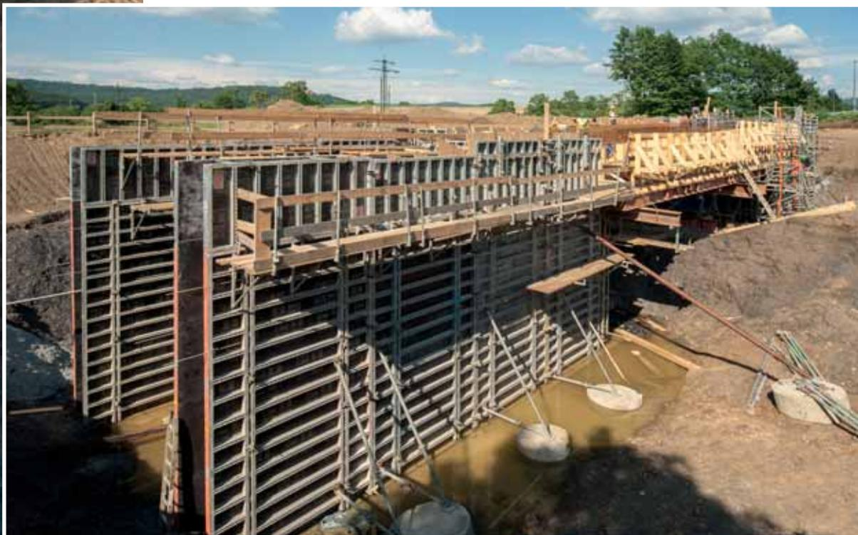
*La courbe décrite par le pont et ses culées inégales furent un réel challenge pour l'entreprise Stark d'Aalen chargée des travaux. Une tâche dont elle est parfaitement venue à bout grâce au coffrage de mur NOEtop.*
