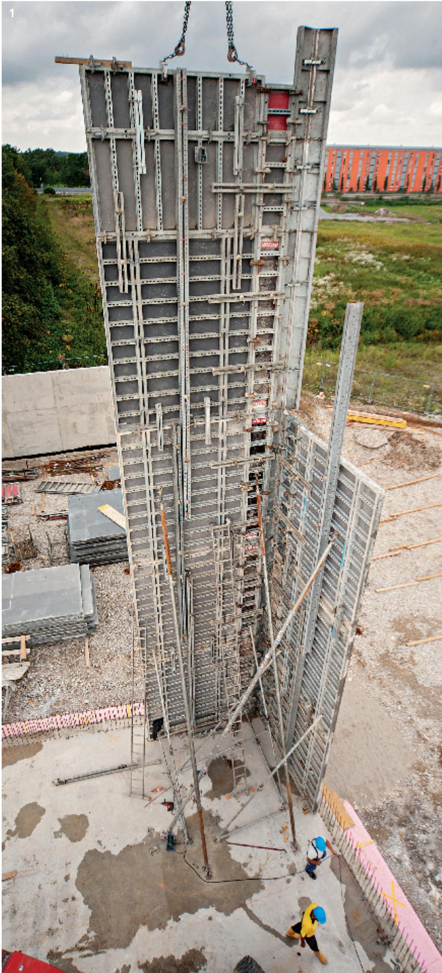
Im Frühjahr 2015 eröffnet in München die größte Kletteranlage Europas. Bei ihrem Bau wurden 15 m hohe Sichtbetonwände in einem Arbeitsgang erstellt. Möglich war dies nur durch die NOEtop, dem bewährten Wandschalensystem von NOE-Schaltechnik.
