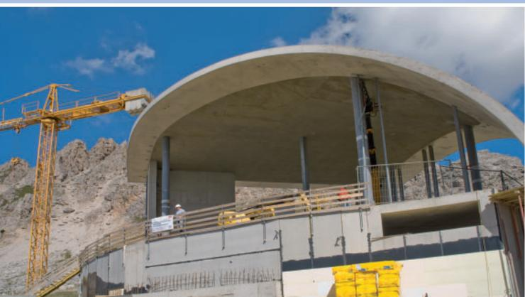
*Un plafond légèrement structuré réalisé à l'aide de matrices de coffrage NOEplast donne un cachet à l'architecture du projet et casse les ondes sonores dans le hall pour garantir une bonne acoustique des lieux.*
