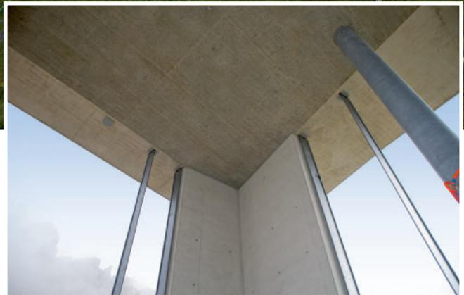
*Le plafond garni de la structure NOEplast crépie Trier 3 assure la bonne acoustique des lieux dans le hall. Au total, près de 400 m<sup>2</sup> de structures de coffrage NOEplast Trier 3 ont été utilisés. La taille homogène des matrices vient renforcer la structure du plafond.*
