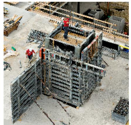
den Vorteil, dass man durch die vertikale Öffnungsbewegung nicht mit der überstehenden Bewehrung in die Quere kommt.
