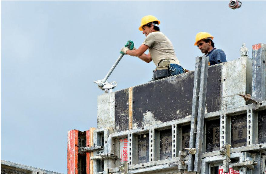
Kranhaken sind an den NOEtop Ausschalecken so angebracht, dass sowohl ein waagerechter Transport der Elemente, z. B. zum Auf- oder Abladen, als auch ein senkrechter Transport, z. B. zur Montage, möglich ist. NOEtop Ausschalecken werden mit dem Standard-Verbindungs mittel der NOEtop, dem NOE Toplock, an der Schalung befestigt. Auch ein Verschrauben ist möglich.
