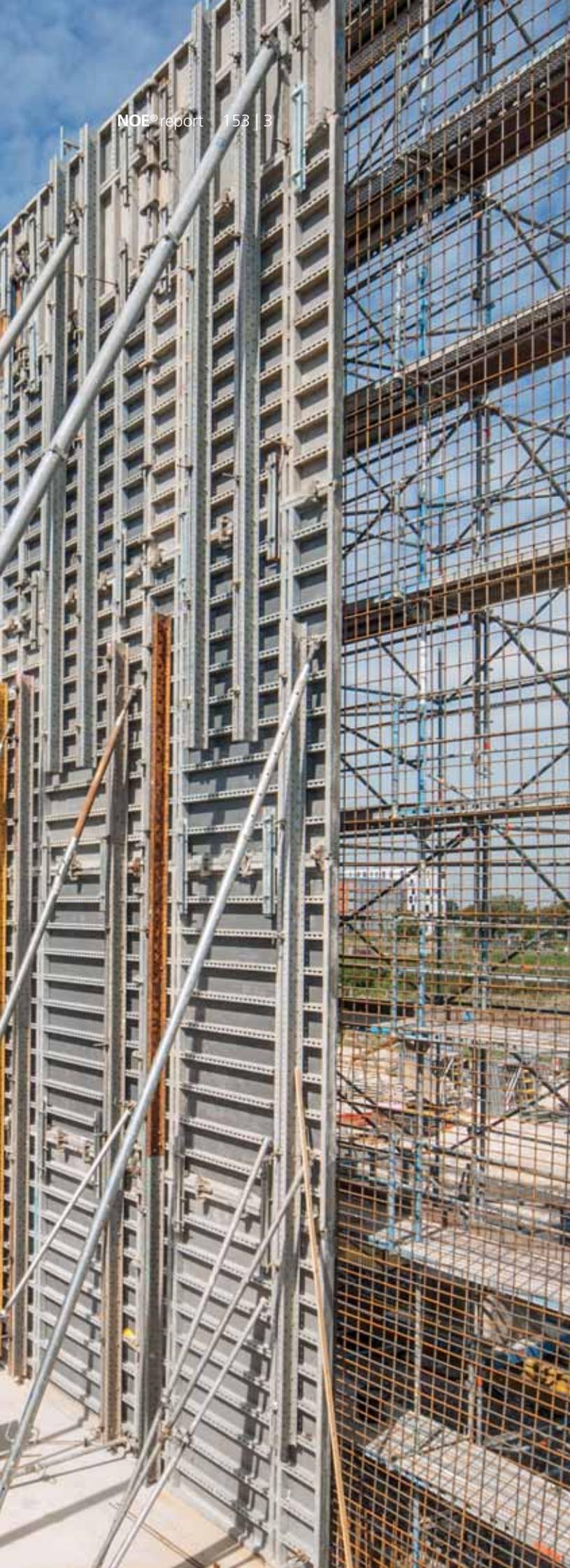
*Le plus grand centre d'escalade d'Europe ouvre ses portes à Munich au printemps 2015. Pour sa construction, des murs en béton apparent de 15 m de haut ont été dressés en une seule opération. Ce procédé est uniquement réalisable grâce à NOEtop, le système de coffrage mural éprouvé de NOE-Schaltechnik, Süssen.*
