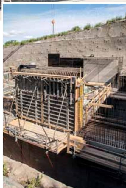
*Le coffrage de mur NOEtop a également servi pour la construction des bâtiments d'exploitation Est et Ouest.*
