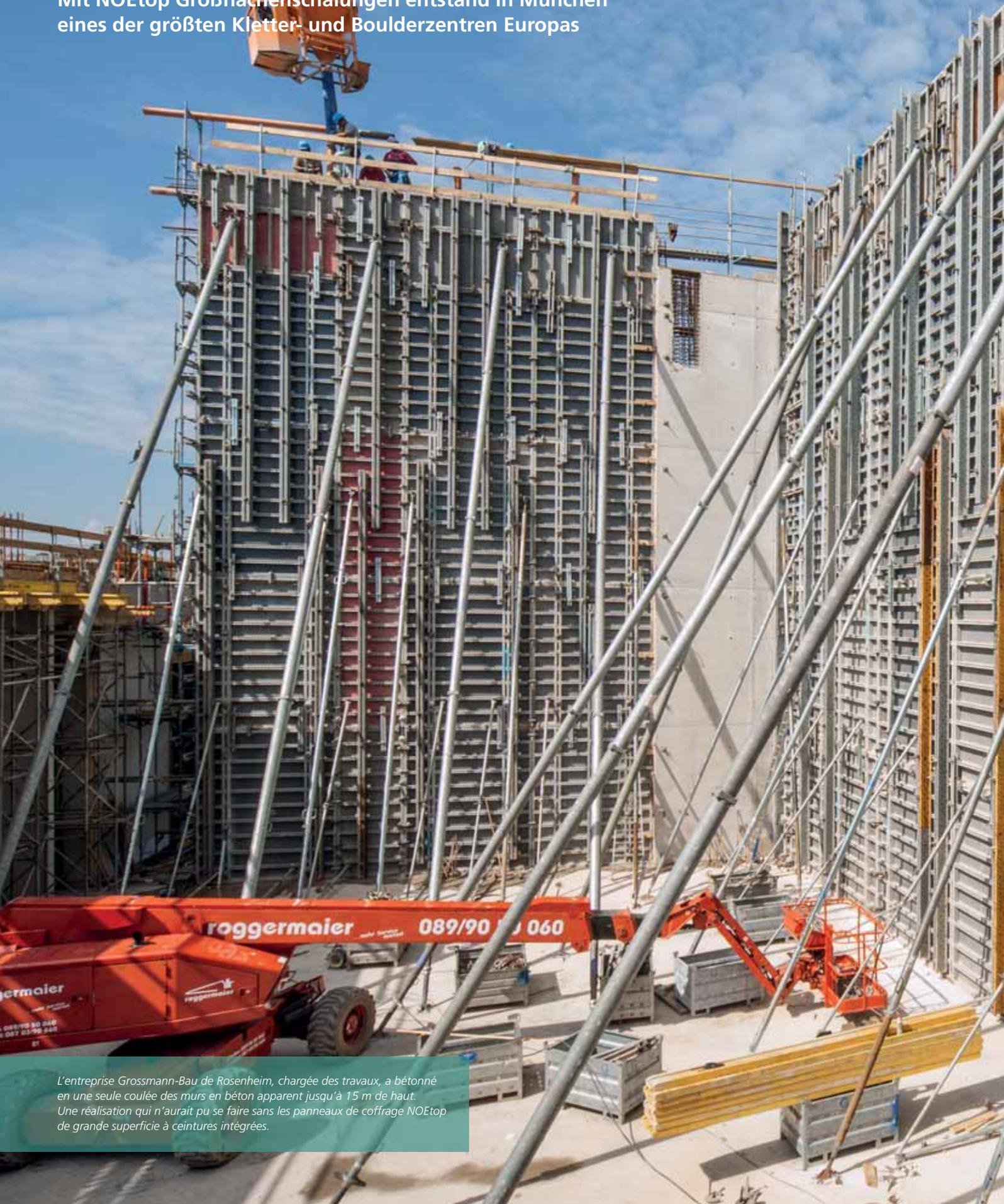
L'entreprise Grossmann-Bau de Rosenheim, chargée des travaux, a bétonné en une seule coulée des murs en béton apparent jusqu'à 15 m de haut. Une réalisation qui n'aurait pu se faire sans les panneaux de coffrage NOEtop de grande superficie à ceintures intégrées.
