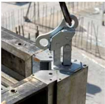
L'emploi d'angles de décoffrage NOEtop rend superflu le démontage du coffrage intérieur, par ex. dans les cages d'ascenseurs ou d'escaliers.
