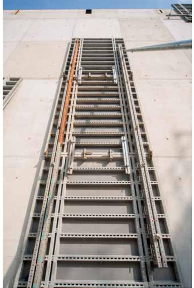
Des murs en béton apparent de 15 m de haut coulés en une seule opération.
