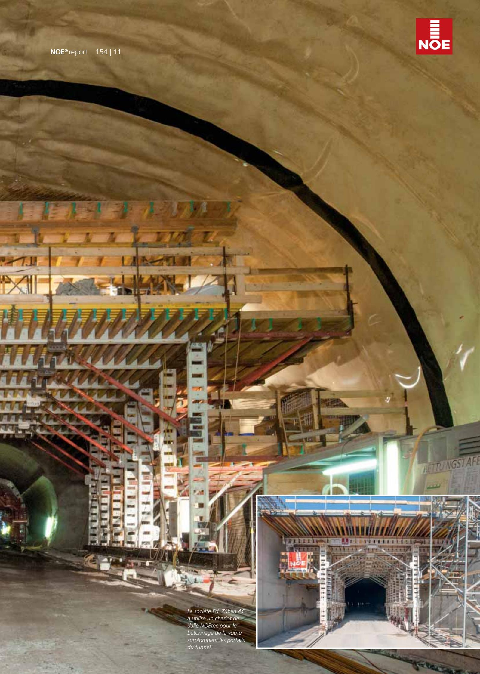
*La société Ed. Züblin AG a utilisé un chariot de dalle NOEtec pour le bétonnage de la voûte surplombant les portails du tunnel.*
