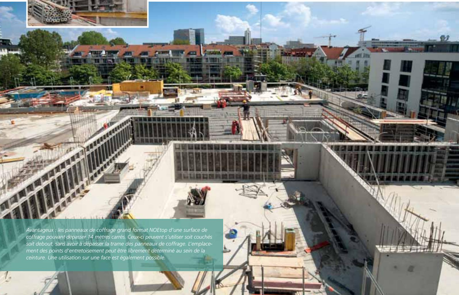
*Avantageux : les panneaux de coffrage grand format NOEtop d'une surface de coffrage pouvant dépasser 14 mètres carrés. Ceux-ci peuvent s'utiliser soit couchés soit debout, sans avoir à dépasser la trame des panneaux de coffrage. L'emplacement des points d'entretoisement peut être librement déterminé au sein de la ceinture. Une utilisation sur une face est également possible.*
