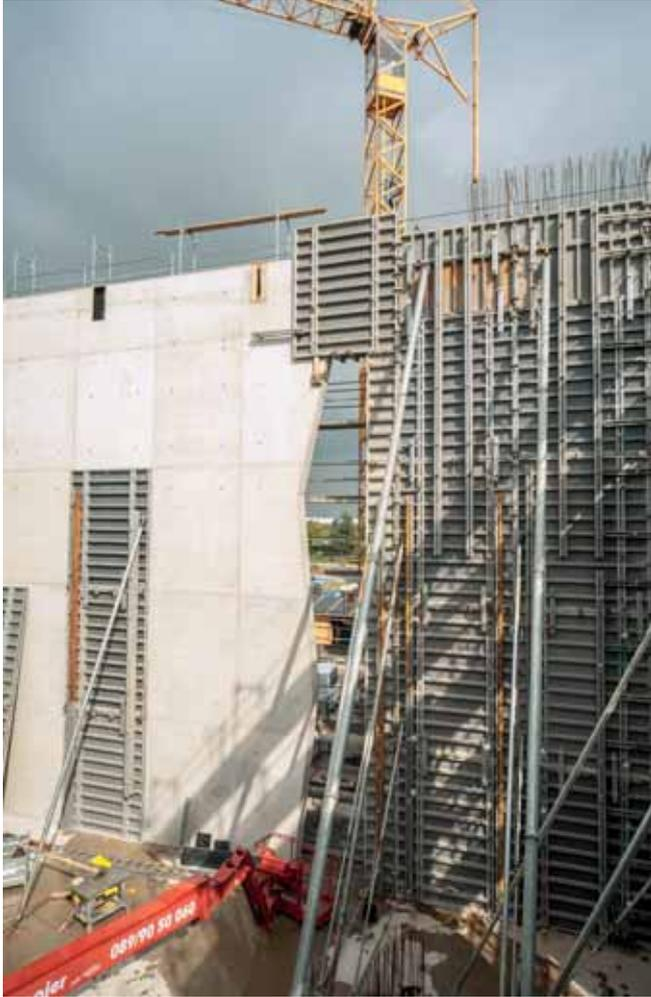
Bien visible la trame continue des panneaux de coffrage avec panneaux utilisés debout et couchés du coffrage de mur NOEtop.
