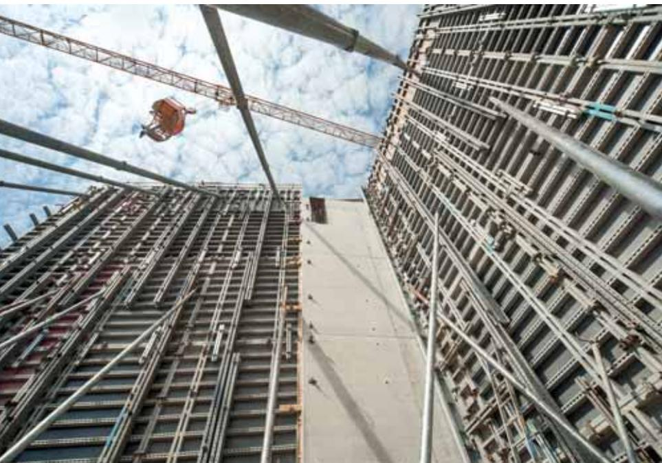
*Grandes hauteurs réalisées à l'appui de la technique de coffrage pour la construction du centre d'escalade et de bloc à Munich-Freimann. Une fois terminé, ce centre sera un complexe parmi les plus grands et les plus modernes du monde.*
