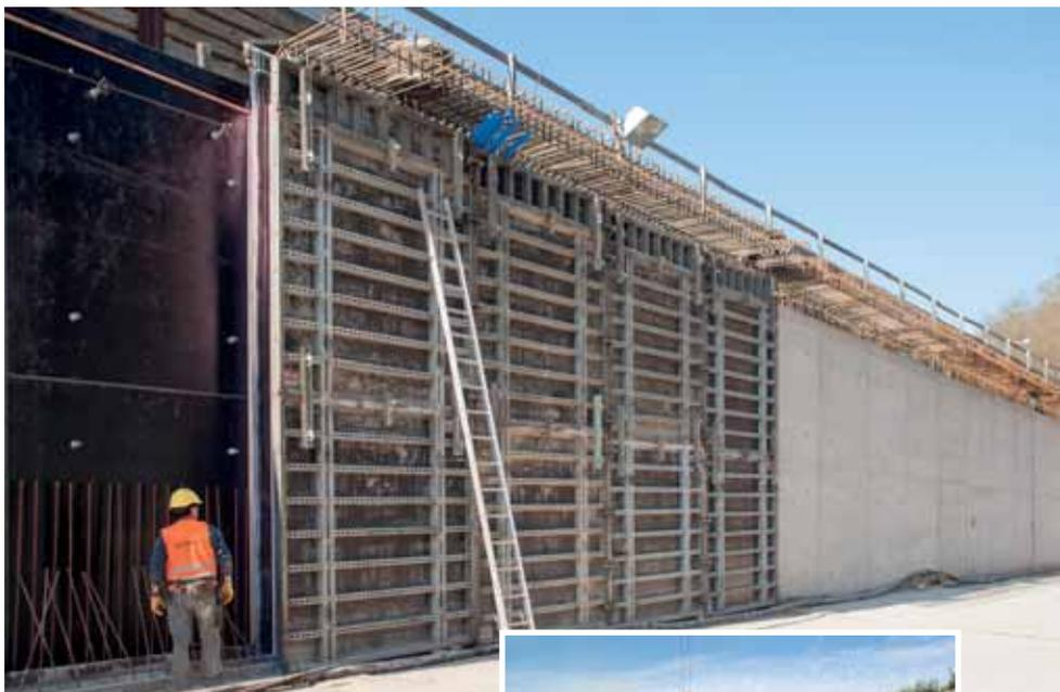
*Le bétonnage des parois des portails du tunnel a été réalisé grâce aux panneaux de coffrage de grande superficie NOEtop. L'emplacement des points d'entretoisement peut être librement déterminé au sein de la ceinture.*
