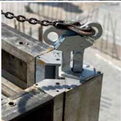
Une fois désolidarisé de la surface bétonnée, le coffrage intérieur se retire à la grue de levage. Un jeu de décoffrage de 40 mm permet un déplacement rapide. Après avoir déplacé le palan, le coffrage intérieur se place à nouveau à l'état de coffrage d'un simple mouvement de grue.
