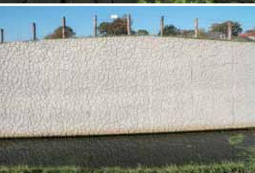
*La nouvelle structure pierreuse NOEplast « Santpoort » rappelle la surface de la terre glaise séchée et fissurée, même lorsqu'elle est partiellement immergée dans l'eau.*
