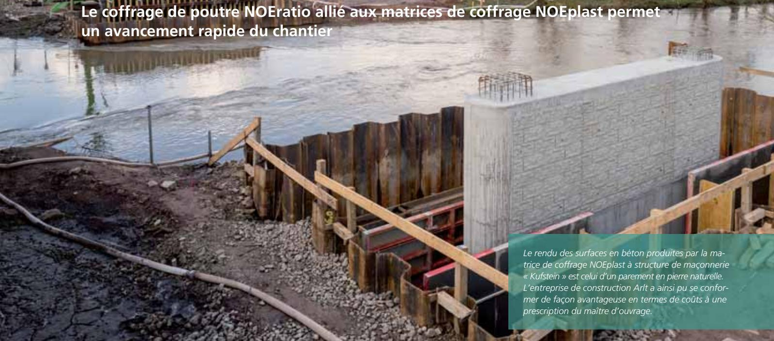
Le rendu des surfaces en béton produites par la matrice de coffrage NOEplast à structure de maçonnerie « Kufstein » est celui d'un parement en pierre naturelle. L'entreprise de construction Arlt a ainsi pu se conformer de façon avantageuse en termes de coûts à une prescription du maître d'ouvrage.
