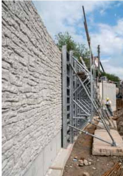
*Du béton apparent sans entretoisement : avec le système NOE Combi 70, l'entretoisement se situe au niveau du socle et par dessus le coffrage.*
