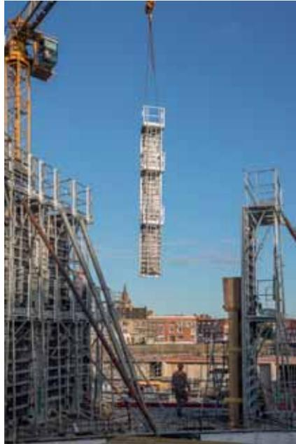
*NOEtop S peut être déplacé sans démontage des plateformes et des échelles d'accès.*
