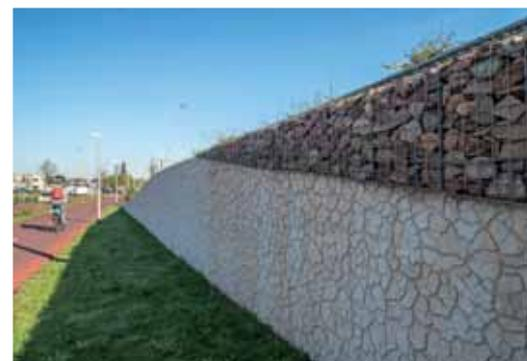
*La reproduction d'une surface en terre glaise séchée et fissurée, à admirer sur un mur de soutènement se trouvant à Velsen aux Pays-Bas. Réalisée avec la nouvelle structure NOEplast « Santpoort ».*
