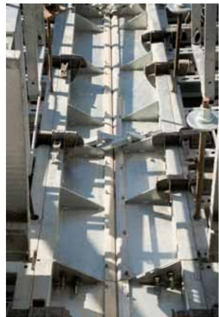
À savoir de plus que les charnières des éléments ne se gorgent pas de béton, ce qui réduit les opérations de nettoyage et d'entretien au minimum requis. La souplesse du mécanisme de réglage facilite par ailleurs grandement les opérations de coffrage et de décoffrage. C'est ainsi que l'entreprise chargée des travaux a pu réaliser sans encombres le coulage dans les parois. Mais ce ne fut pas le seul défi à relever.
