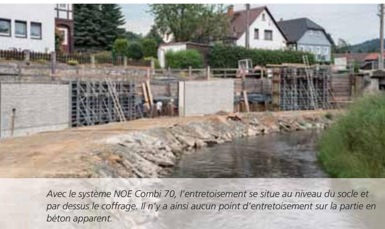
Avec le système NOE Combi 70, l'entretoisement se situe au niveau du socle et par dessus le coffrage. Il n'y a ainsi aucun point d'entretoisement sur la partie en béton apparent.
