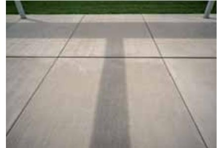
NOEplast Sydney : structure aux fines rayures à la façon d'un coup de balai sur des plaques en béton de grand format.
