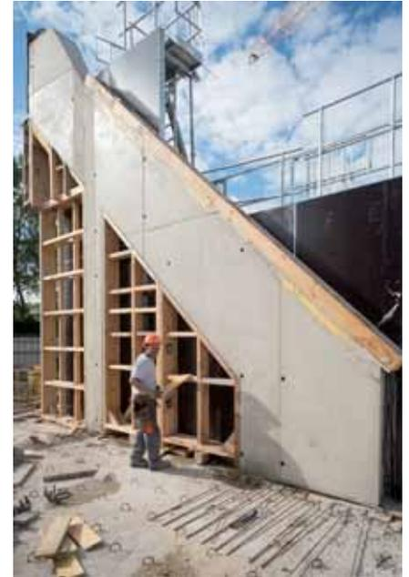
*NOEtop S a également convaincu par la qualité du rendu des surfaces en béton apparent.*
