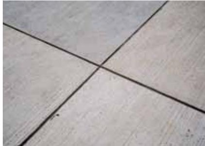
La surface des éléments préfabriqués en béton a été traitée avec un produit déperlant.
