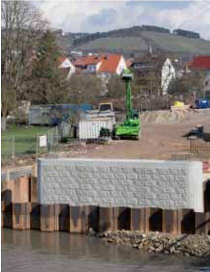
Le rendu des surfaces en béton des culées et piles produites par la structure maçonnée NOEplast « Kufstein » est celui d'un parement en pierre naturelle.
