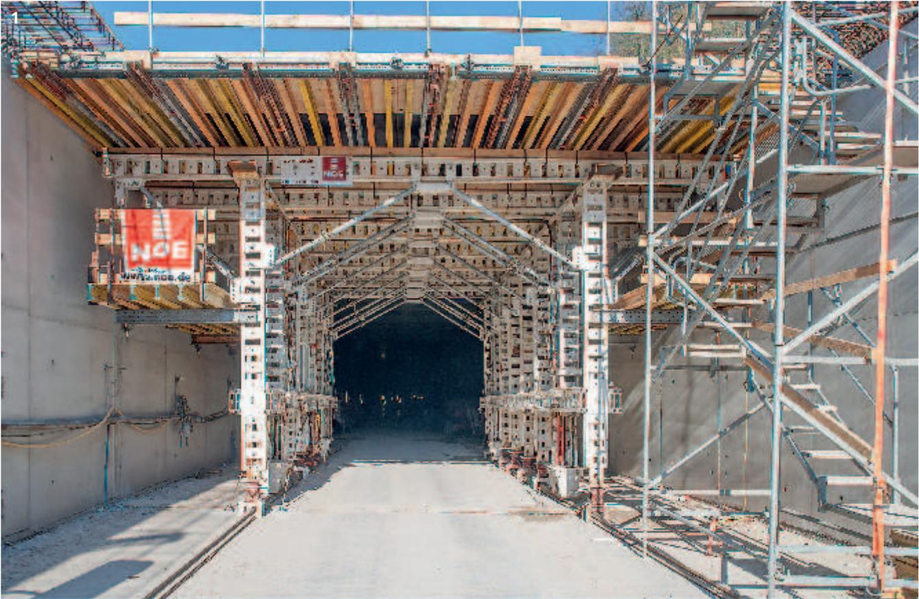
*Im Zuge der Ortsumfahrung der Stadt Schriesheim erfolgt der Bau des 1796 m langen Branich-Tunnels. Für den Bau des Tunnels entwickelte NOE-Schaltechnik mit seinem äußerst flexiblen Schalungssystem für Ingenieurbauwerke NOEtec zwei Schalwagen, die völlig unterschiedliche Aufgaben zu erfüllen hatten und deren Größe zum Teil veränderlich sein musste.*
