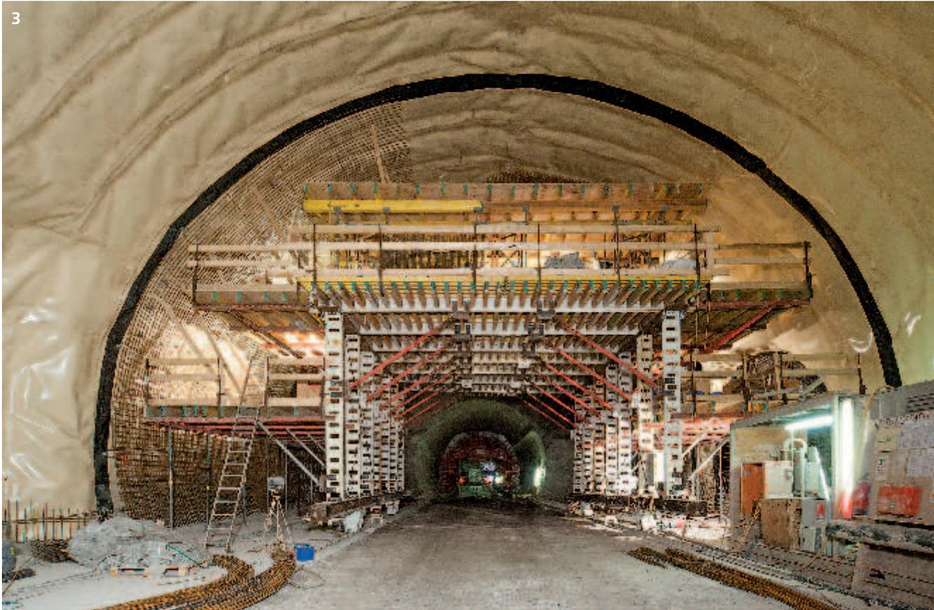
fläche von ca. 100 m<sup>2</sup> in einem Arbeitsgang betonieren. Nach dem Aushärten des Betons wurde der Schalwagen mit Hilfe einer Hydraulik um ca. 20 cm abgesenkt und der Schalwagen zum nächsten Abschnitt verfahren. Für die Rückunterstützung verwendete Züblin NOE LS 200 Schwerlaststützen.
