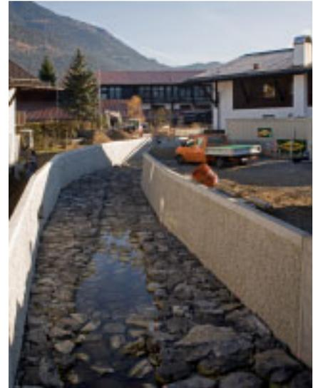
Das neue Gerinne der Kanker kurz vor seiner Fertigstellung. Mit etwas „Patina“ wird nur noch der Fachmann erkennen können, dass es sich bei den Seitenwänden um Betonwände handelt.
