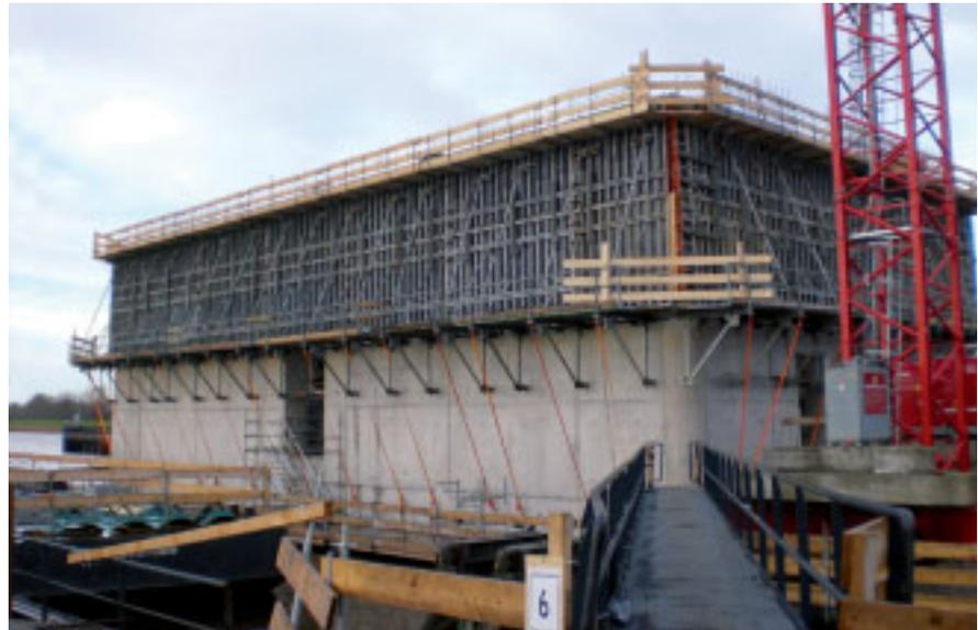
Geklettert wurde mit der klappbaren Arbeitsbühne NOE AB 300. Ein besonderer Vorteil war, dass die Anker in den Spannstellen der NOEtop gesetzt werden konnten.
