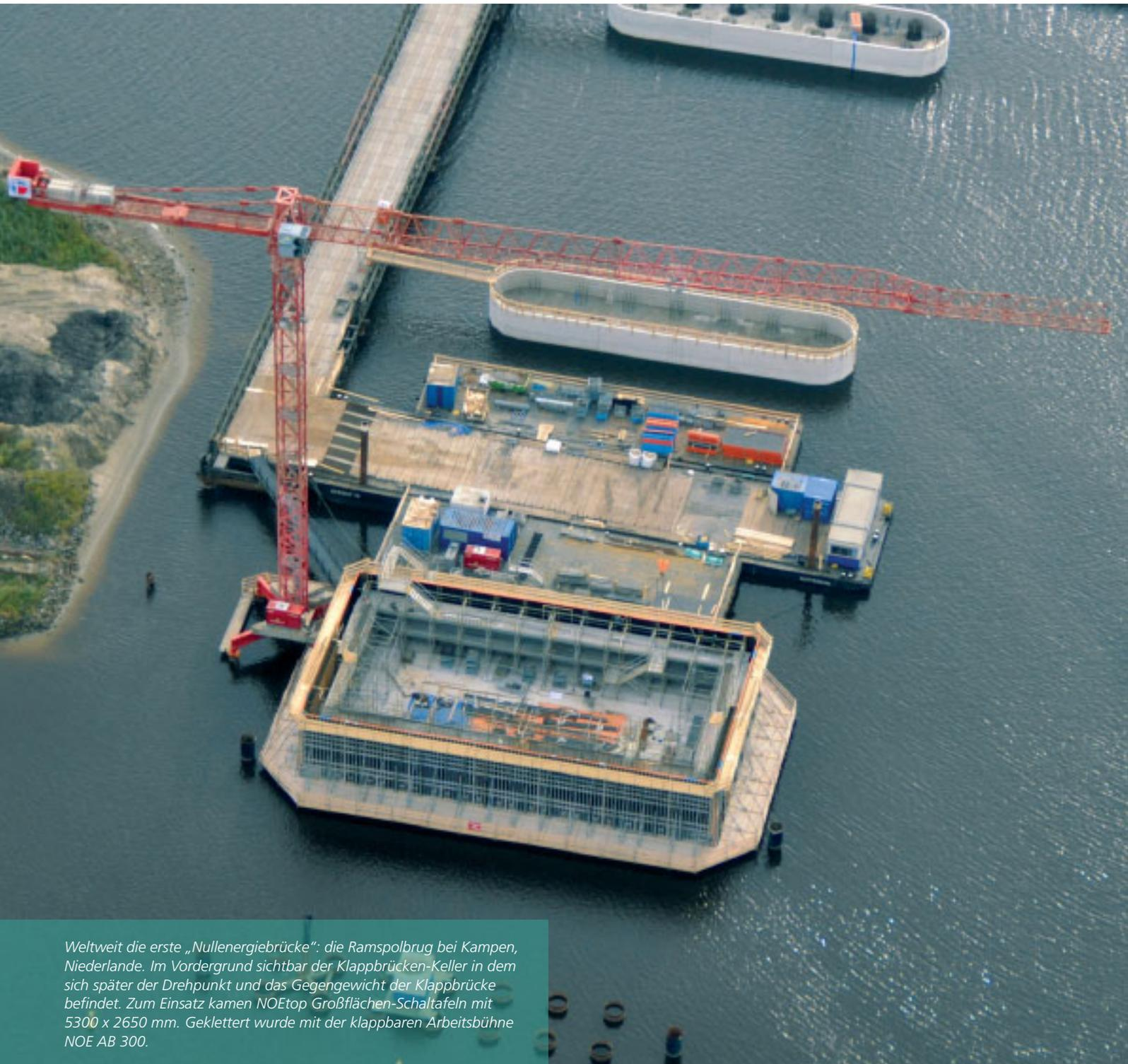
Weltweit die erste „Nullenergiebrücke“: die Ramspolbrug bei Kampen, Niederlande. Im Vordergrund sichtbar der Klappbrücken-Keller in dem sich später der Drehpunkt und das Gegengewicht der Klappbrücke befindet. Zum Einsatz kamen NOEtop Großflächen-Schalttafeln mit 5300 x 2650 mm. Geklettert wurde mit der klappbaren Arbeitsbühne NOE AB 300.
