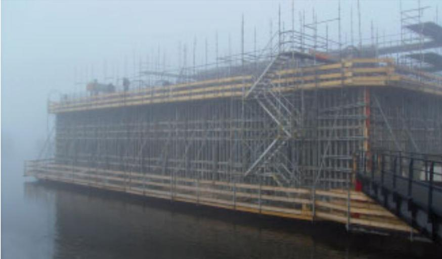
Jeweils zwei NOEtop Großflächen-Schaltafeln wurden zu einer umsetzbaren Einheit mit 5300 x 5300 mm und über 28 m<sup>2</sup> Schalfläche verbunden.
