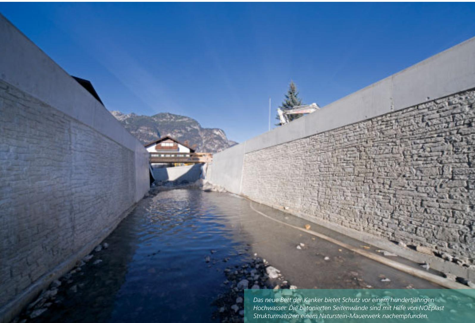
*Das neue Bett der Kanker bietet Schutz vor einem hundertjährigen Hochwasser. Die betonierte Seitenwände sind mit Hilfe von NOEplast Strukturmatrizen einem Naturstein-Mauerwerk nachempfunden.*
