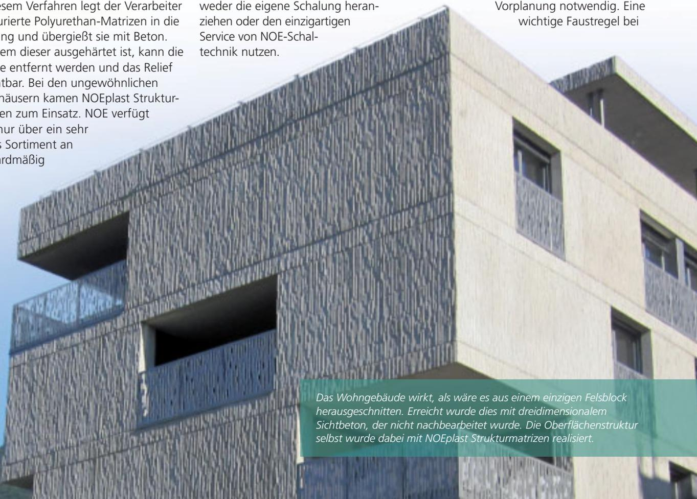
*Das Wohngebäude wirkt, als wäre es aus einem einzigen Felsblock herausgeschnitten. Erreicht wurde dies mit dreidimensionalem Sichtbeton, der nicht nachbearbeitet wurde. Die Oberflächenstruktur selbst wurde dabei mit NOEplast Strukturmatrizen realisiert.*
