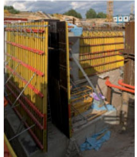
*Die Höhe der geneigten Schleusenwände beträgt bis zu 7 m. Hier überzeugte die NOE H 20 Trägerschalung besonders durch ihren strukturierten Aufbau.*
