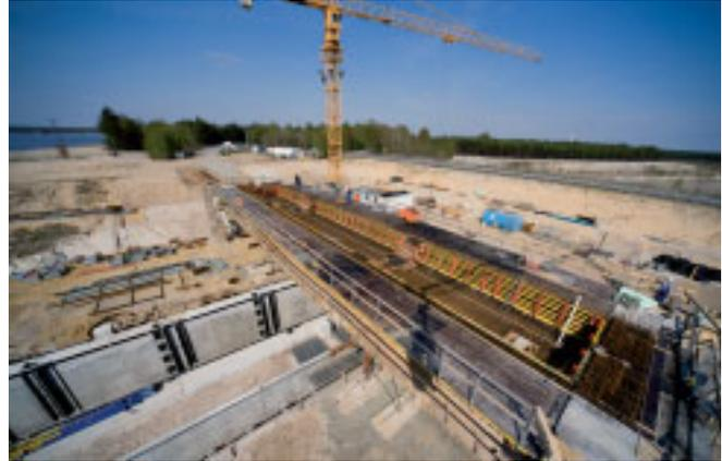
Über 95% betrug der Anteil an standardisierten Schalelementen bei der Schalung für den Hohlkasten der Brücke.
