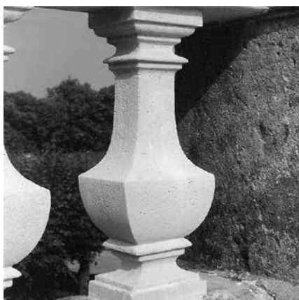
Mit Weißzement und Sand sowie durch Sandstrahlen erreicht man perfekte Nachbildungen.
