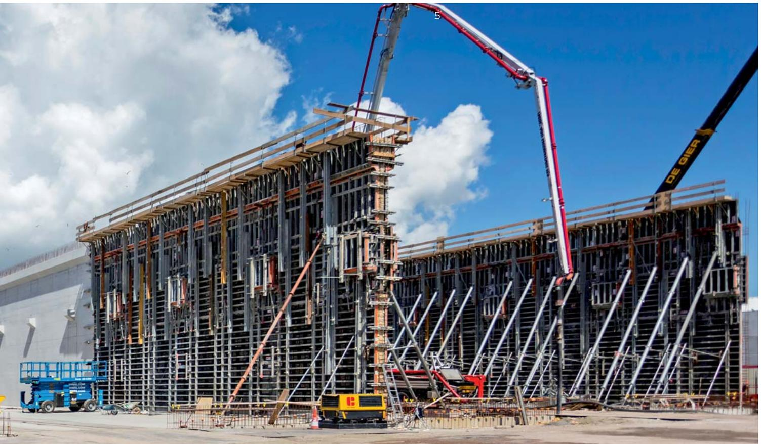
besteht das Dach des Gebäudes aus Betonfertigteilelementen. Sie wurden auf die durchgehenden Konsolen gelegt, die den oberen Wandabschluss bilden. Um die Auflagerkonsolen und die Wände aus einem Guss fertigen zu können, bauten die Verantwortlichen aus NOE Combi 20 Trägern einen Schalungskasten mit den erforderlichen Abmessungen und verbanden diese mit der NOEtop Schalung. So bilden Wand und Konsole eine Einheit.
