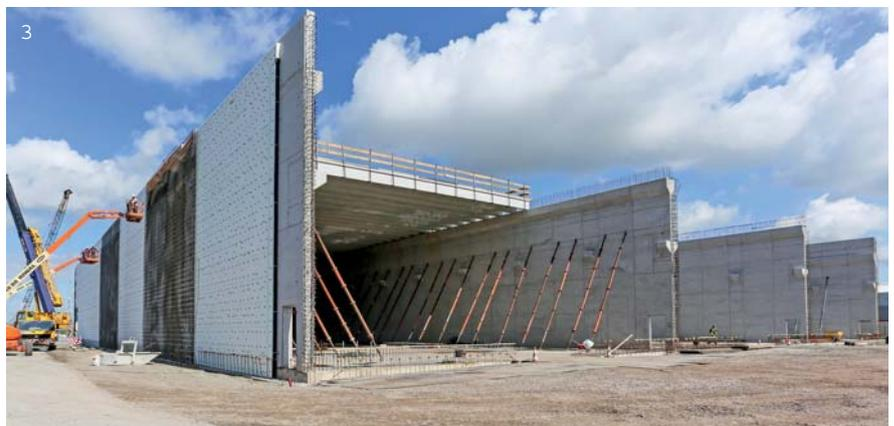
Titelfoto: Die Auflager für Kranbahnen und für die Betonfertigteile der Dachkonstruktion wurden gemeinsam mit den Wänden in einem Guss betonierte.
