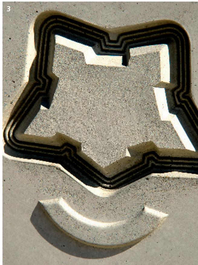
Um die Motive auf die Betonoberflächen zu übertragen wurden NOEplast Strukturmatrizen eingesetzt. Hierbei werden die aus PU bestehenden Strukturmatrizen in die Schalung geklebt oder gelegt. Anschließend wird betoniert. Sobald der Beton ausreichend ausgehärtet ist, kann ausgeschalt werden, wodurch die gewünschte Oberflächenstruktur zum Vorschein kommt.
