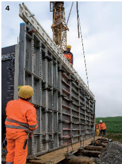
den üblichen – es können auch annähernd alle Betonsorten eingesetzt werden. Sobald der Beton ausreichend ausgehärtet ist, lässt sich die Schalung mit der Matrize entfernen und die gewählte Struktur wird sichtbar.
