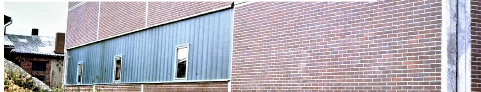
Bei dieser Matrize handelt es sich um eine Besonderheit. Sie dient nicht dazu, eine Struktur auf die Oberfläche des Betons zu zaubern. Stattdessen werden in sie Klinkersteine eingelegt, die dann mit Beton übergossen werden. Diese gehen so eine dauerhafte Verbindung mit dem Kunststein ein und eignen sich gut für Fassaden, die an eine klassische Klinkerwand erinnern.
