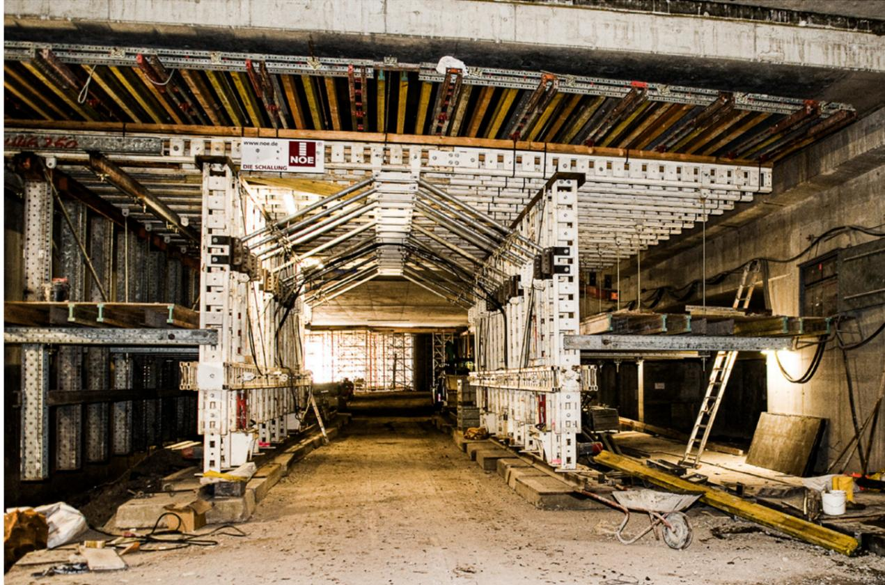
Der Tunnel Wagenladungsstraße ist ein Straßentunnel in Stuttgart-Mitte und dient der Erschließung des Europaviertels und des Milaneo Einkaufszentrums am Stuttgarter Hauptbahnhof. Beim Bau des Tunnels kamen zwei höhenverstellbare NOEtec Deckenschalwagen zum Einsatz: Im Bereich „Londoner Straße“ ein zweifach höhenverstellbarer und im Bereich „Milaneo“ ein dreifach höhenverstellbarer Schalwagen.
