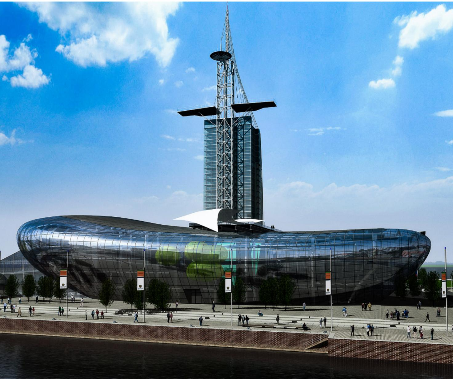
Durch die schiffsähnliche Form galt das Gebäude im ersten Anlauf zunächst als unrealisierbar. Die 1.200 Tonnen schwere Unterkonstruktion umschließt das Gebäude. Hierfür kam die NOEalu L zum Einsatz.
