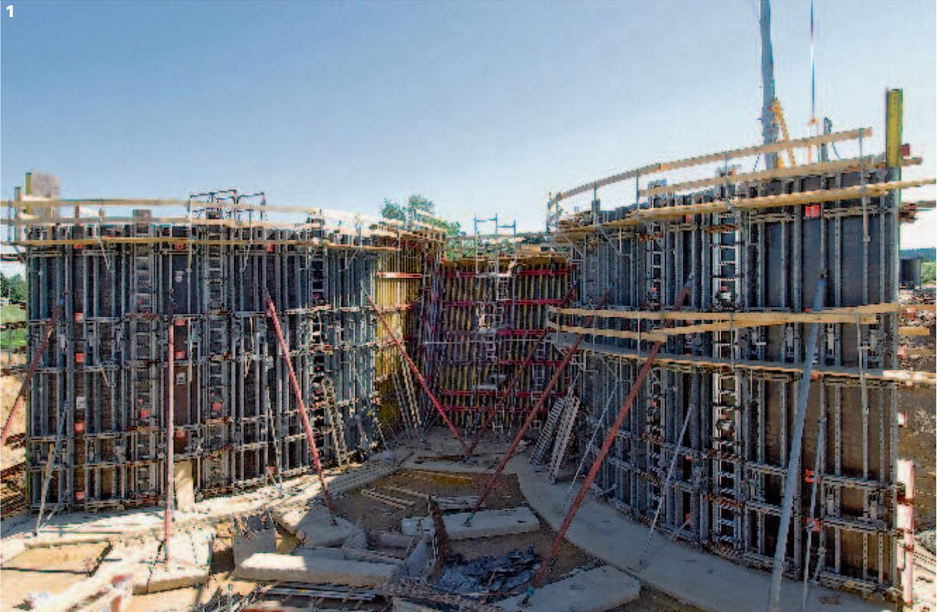
Bei Chemnitz/Adelsberg führt eine Brücke über die neue Bundesstraße B 174. Die ungewöhnliche Form der Flügelwände eines ihrer Widerlager machte den Einsatz einer Rundschalung notwendig. Darüber hinaus zeichnet sich das Bauwerk durch seine besondere Oberflächengestaltung aus. Für das Strukturieren der Sichtbeton-Oberflächen kamen abgesetzte, glatte Schalbeläge mit aufgedoppelten Dreikantleisten zum Einsatz.
